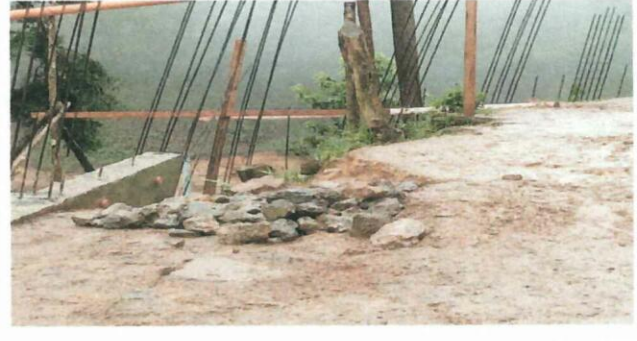
Foto 2: Fotografia del seguimeinto de construccion de muro.
