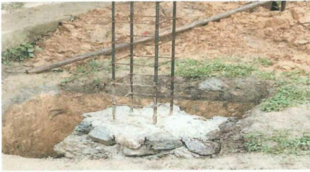
Foto1: Foto de la cumalpa del muro de contencion.
