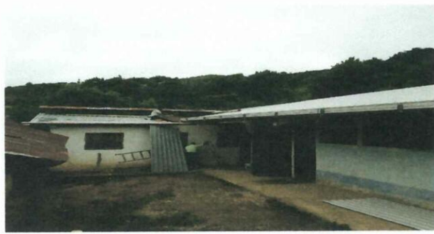
Foto 3: foto de cambion de lamina de cocina.
