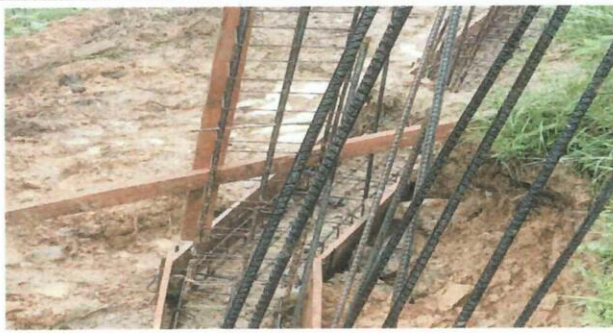
Foto 5: Foto del proceso de construccion del muro.
