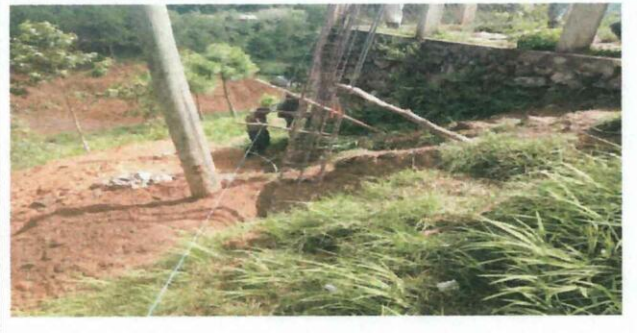
Foto 6: Foto del cimeinto de muro de contencion
